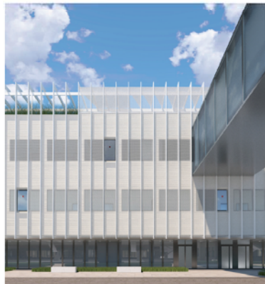
Image 29 - Vue du bâtiment L depuis l'allée Jardin
